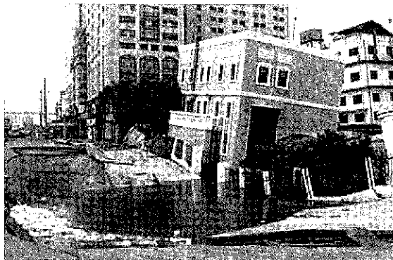
写真一 上海地下鉄4号線トンネル陥没事例(11)
