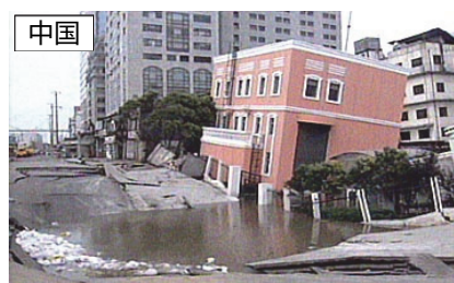
中国 上海地下鉄4号線修復工事の技術支援
