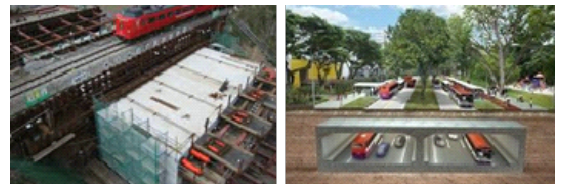
函体推進工法による地下道路の建設
