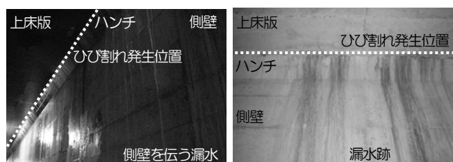
図-14 とう道内の漏水状況
