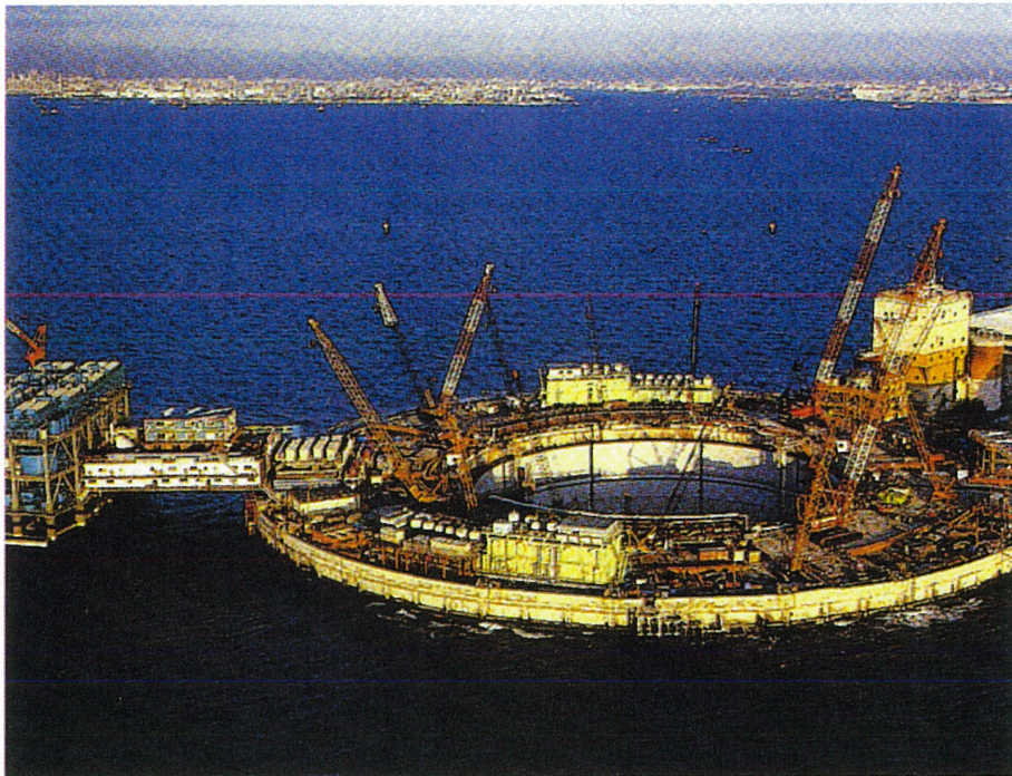
口絵写真一24 川崎人工島（風の塔）の工事全容
