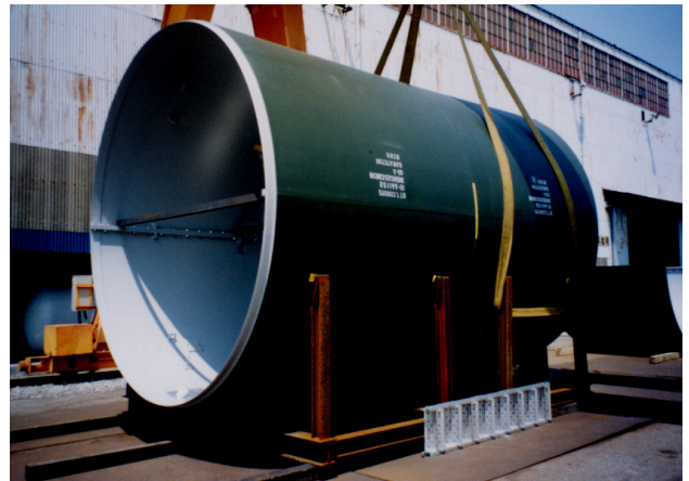
写真-3 地上組立後の二分割鋼管セグメント
