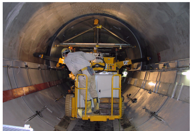
写真-4 上部鋼管セグメント搬入および組立状況
