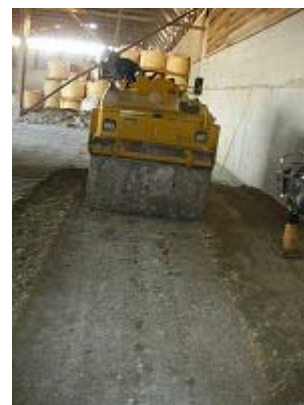
写真-1 凸部転圧状況
