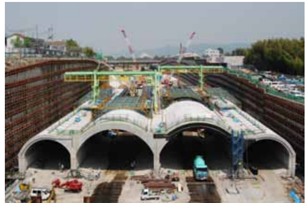
写真-1 現場全景(大阪方より京都方)
