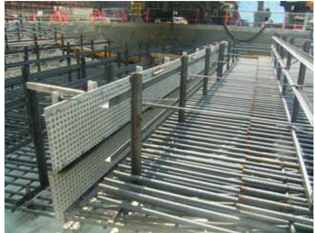
写真-3 埋設型枠設置状況(底版)
