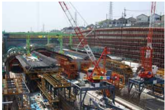
写真-2 現場全景(京都方より大阪方)
