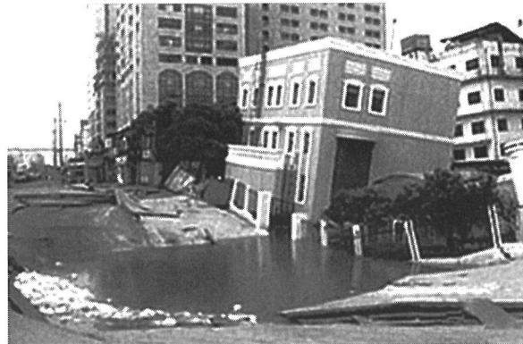
2003年に発生した上海地下鉄4号線連絡横坑構築時の大量出水に伴う大陥没の状況を示す<sup>3)</sup>。
