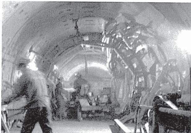
写真-1 凍結管削孔
