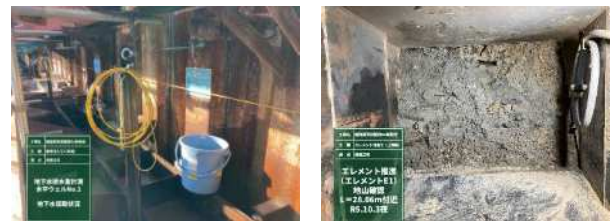
写真-3, 4 水平ウェル排水状況 (左) 切羽状態 (右)
