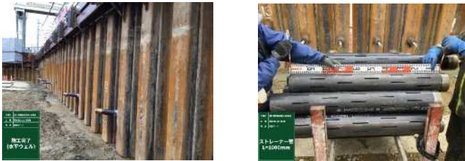
写真-1, 2 水平ウェル設置完了 (左) 有孔管 (右)
